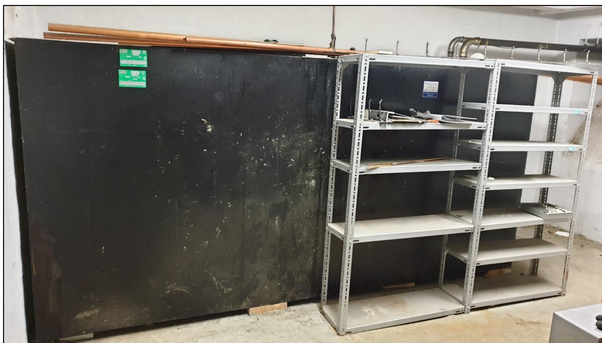
Figur 2. Cistern för eldningsolja om 5 m 3 i källarplan på Björkeby 1:276
